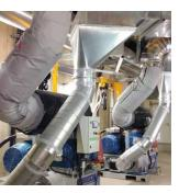
Der weltweit bekannte Hefe-Hersteller vertraut auf Robuschi Robox Screw zur Erzeugung der Verflüssigungsluft für den Fermenter.
