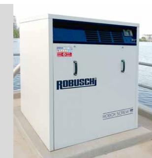
Il cliente ha deciso di installare Robox Screw con la funzione di creare una barriera di bolle d'aria evitando l'ingresso di oggetti galleggianti ed estranei nel molo. Il risultato è stato soddisfacente per robustezza ed affidabilità del gruppo in condizioni di esercizio gravose.
