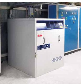
Un noto produttore di pasta e prodotti da forno si è affidato a Robox Screw per il trasporto pneumatico di farina e zucchero. In quanto garantisce temperature operative inferiori, non presenta alcun pericolo di deterioramento del materiale trasportato oltre ad un elevato rendimento energetico.
